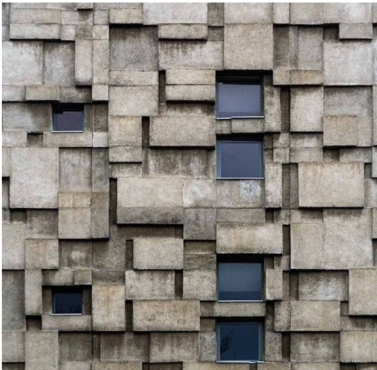
Détail de la façade du bâtiment des Telecoms de Cluj-Napoca
